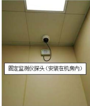
固定监测仪探头(安装在机房内)
