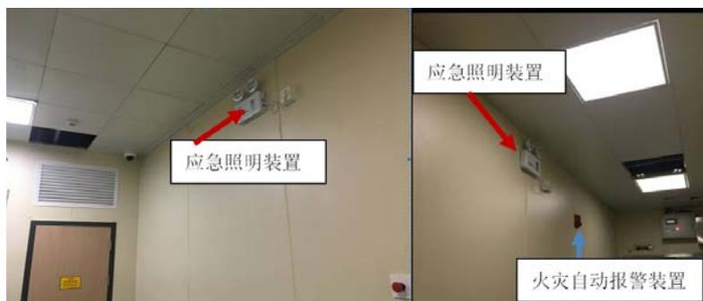
治疗室安装应急照明装置，设火灾自动报警装置等
