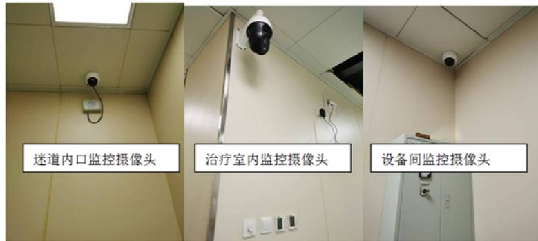
治疗室、迷道、以及设备间闭路监视摄像头（机房门外1个、迷道内入口1个、机房内5个），机房无四角。
